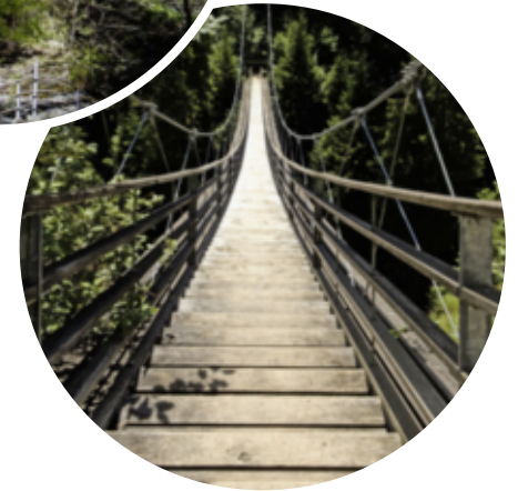
Le Traversina Steg, long de 56 mètres affiche un dénivelé de 22 mètres.
